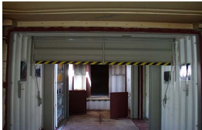
Abbildung 1.4.4: heruntergeklappte Rauchschrürze (Nds. LFS Celle)
