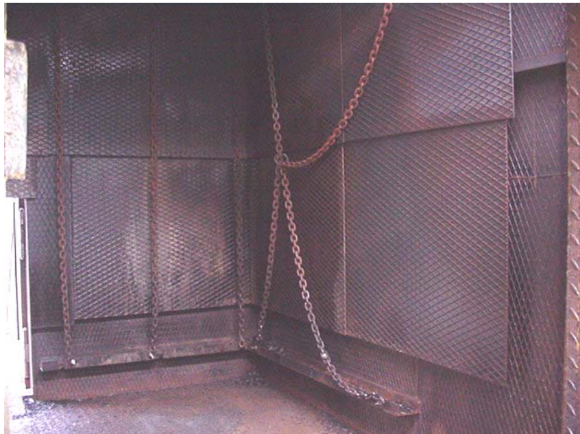
Abbildung 1.2.2: Brandraum mit Isolierung aus Stahlplatten (Feuerwehr Düsseldorf, Engels)
