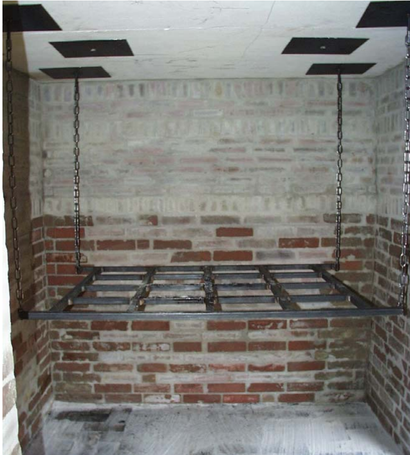
Abbildung 1.2.1: Brandraum mit feuerfesten Klinkern (Nds. LFS Celle)
